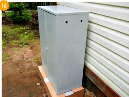
14 Шкаф для газовых баллонов установлен на фундамент.
