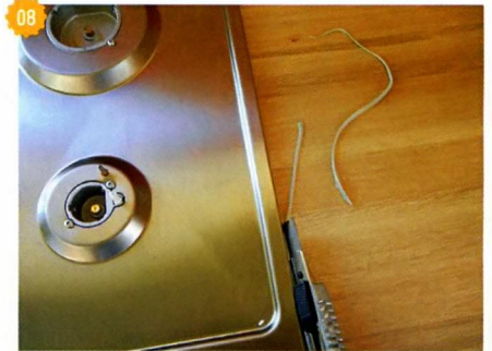
08 Излишки уплотнительной ленты вокруг варочной панели обрезаем.
