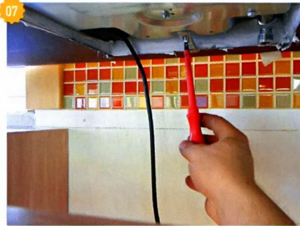
07 Закрепляем варочную панель в столешнице.
