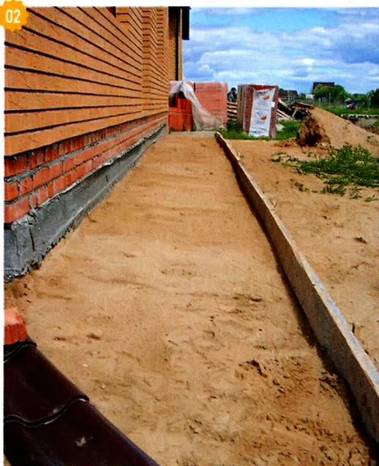
02 Опалубка установлена.
