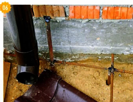
06 Сварной контур заземления.
