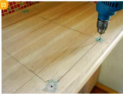
03 Сверлим отверстия по углам проёма в столешнице...
