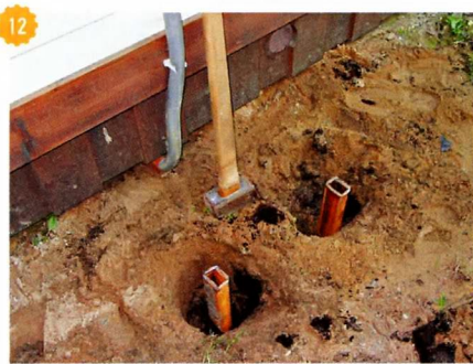
12 Забитые в грунт трубы станут частью фундамента и одновременно заземлением для шкафа.
