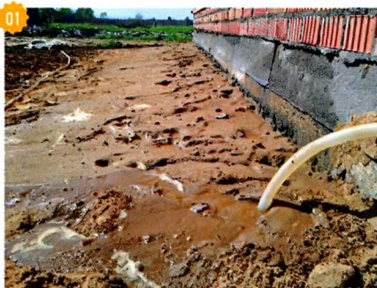
01 После отсыпки основания песок утрамбовал проливкой.
