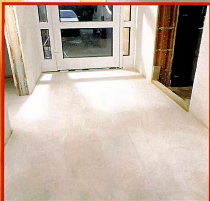
Плавающее ангидритовое основание пола полностью готово к облицовке: отшлифовано и очищено от пыли. Стены оштукатурены.
