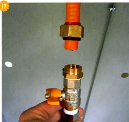
17 Подключение отсекающего вентиля в газовом шкафу.
