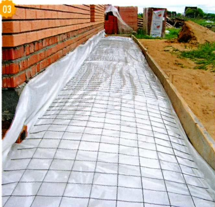
03 На дно опалубки постелил полиэтиленовую плёнку, на которую уложил арматурную сетку.
