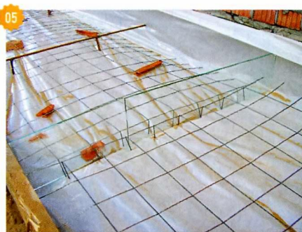
05 В швах концы сетки загнул вниз и установил в качестве вкладышей обрезки стекла.
