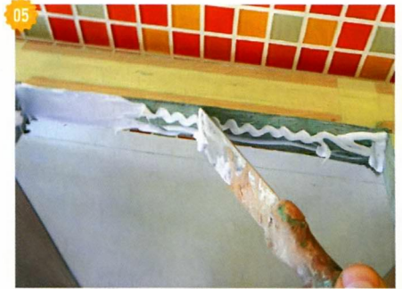
05 Наносим силиконовый герметик на кромки проёма в столешнице.
