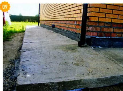
09 Отмостка готова. В будущем на неё обязательно положу тротуарную плитку.
