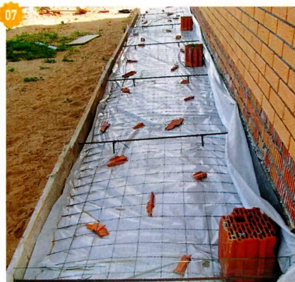
07 В местах, где в последующем будут стойки веранды, в отмостку перед заливкой поставил обломки керамических блоков.
