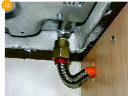
16 Подключение газовой варочной панели к внутреннему газопроводу.
