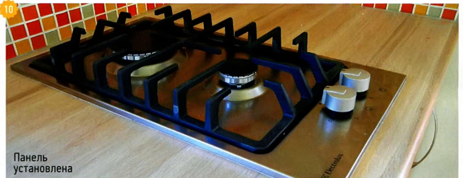
07 Закрепляем варочную панель в столешнице.
