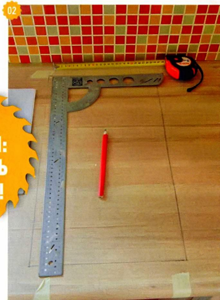
02 Разметка проёма для установки газовой варочной панели.
